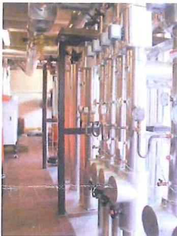
Einsatz von Differenzdruck- und Durchflußreglern in den Unterstationen
