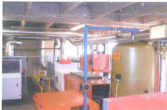
Einbindung der neuen Kesselanlage in die vorhandene Heizungsanlage
