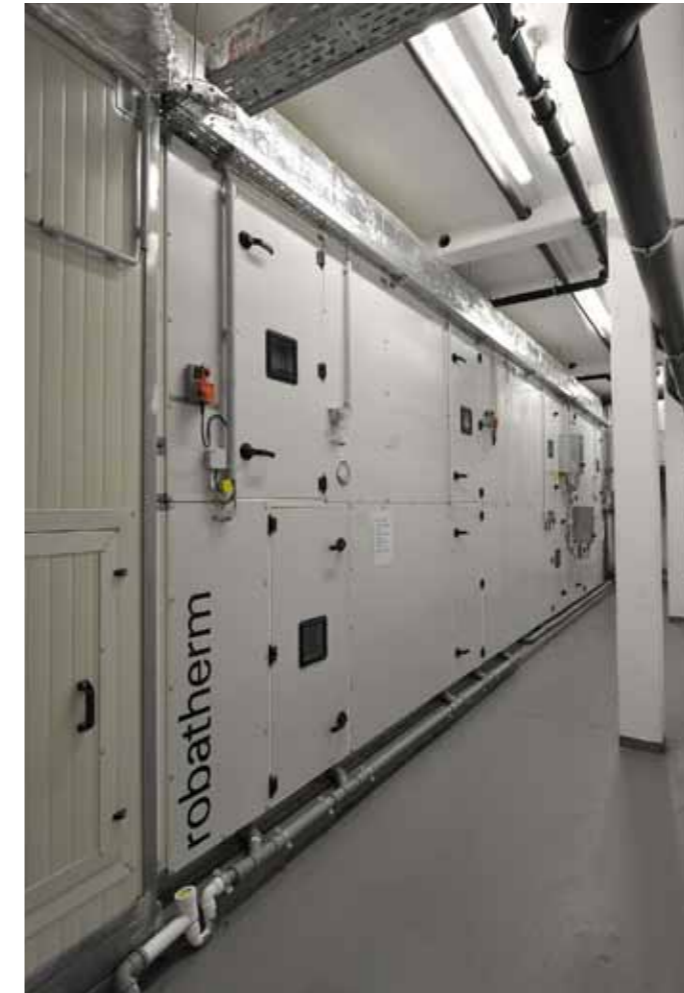
▲ Erneuerung der Anlagentechnik
